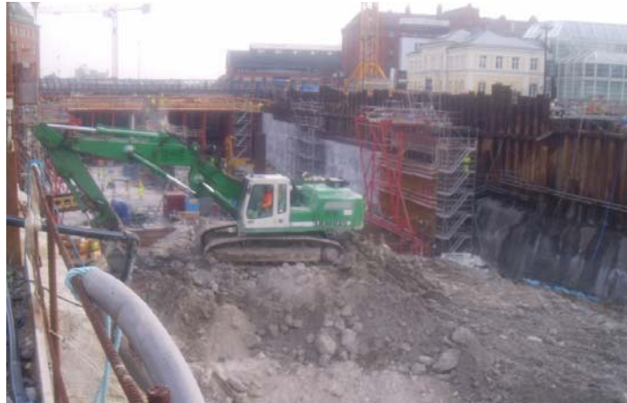
Figur 11.2 Schaktarbete vid Malmö C (2006-10-18)
