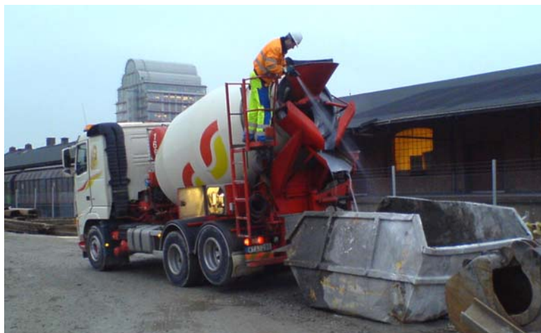
Figur 9.1 Omhändertagande av betongrester för att minska risken att länsvattnet överskrider tillåtna värden.
