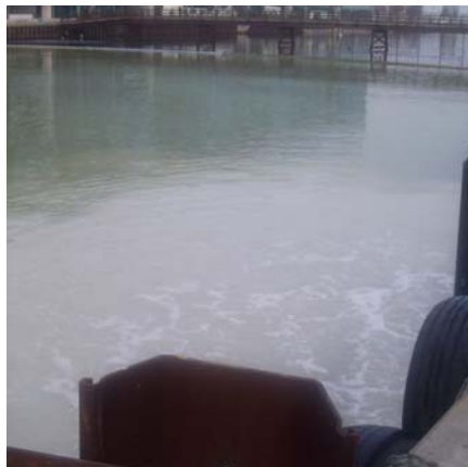
Figur 11.12. Inre hamnen. Bild tagen vid utloppet från sedimentationscontainrarna. Längst upp i bilden syns siltgardinens övre kant.
