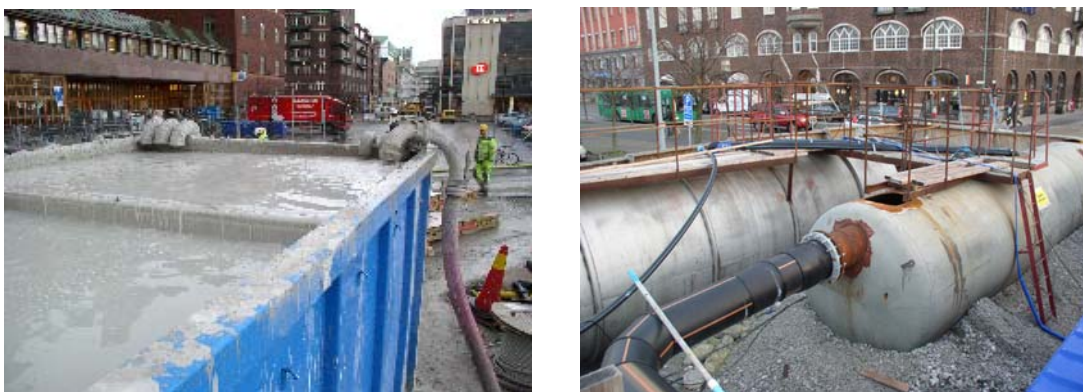
Figur 9.4 Exempel på sedimentationsfällor från Citytunnelprojektet i Malmö. Fotot till vänster visar en sedimentationscontainer och till höger en slamavskiljare.
