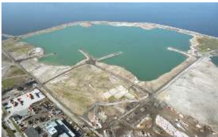
Figur 9.6 Norra hamnen i Citytunnelprojektet har vallats in och skapar en sedimentationsdamm. Dammen fylls successivt igen med genererade schaktmassor från Citytunnelprojektet (Citytunneln, 2007) .
